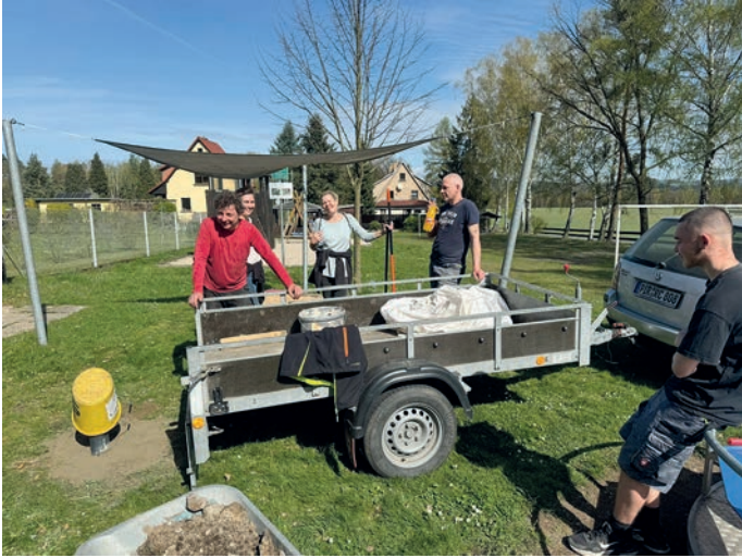
Der Stahlfuß (li. im Bild) für die neue Wellnesliege auf dem Spielplatz ist einbetoniert. Foto: A. Schneider
