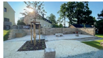
Instandgesetzter Weg im Stillen Grund
